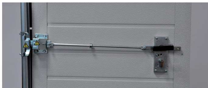
YALĂ REZIDENȚIALĂ, INTERIOR (FOTO 5)
